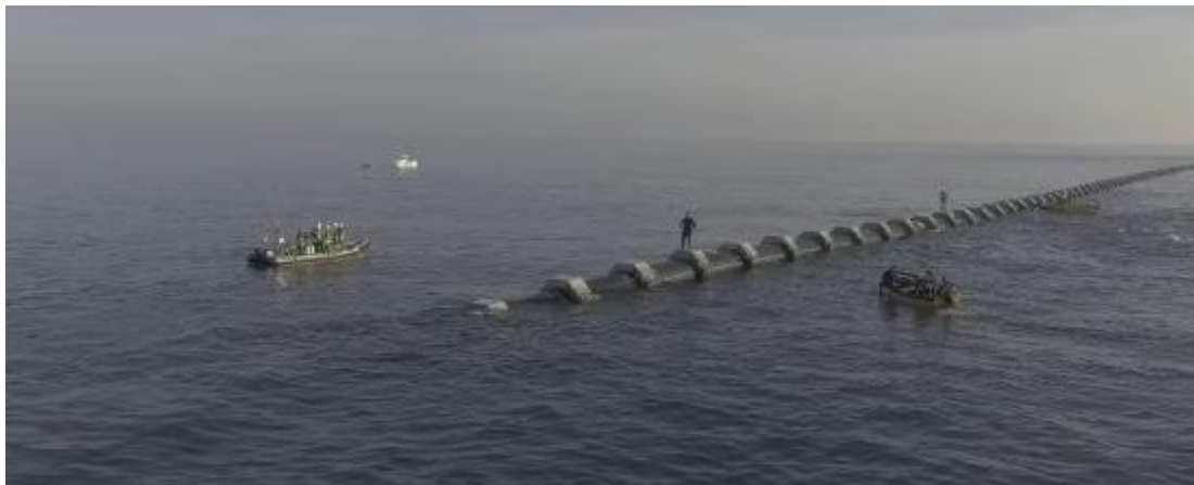
Figura 4.24 Exemplo de colocação de emissário de grandes dimensões (em afundamento)
