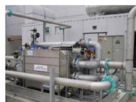
Equipamentos de remoção de siloxanos
