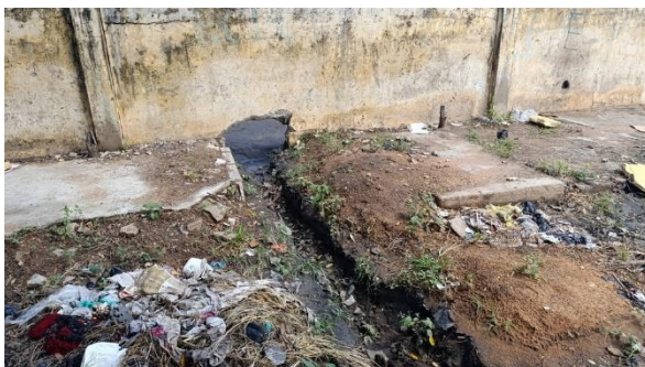
Muro limitante aberto para escoamento de águas
