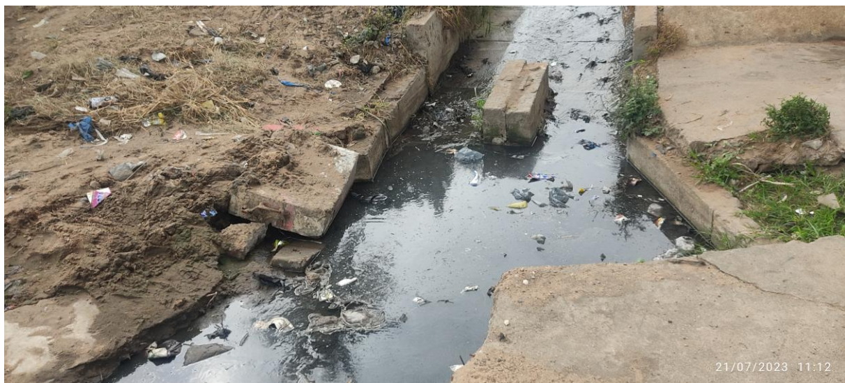
Figura 3-2: Malanga – Vala Existente – Troço 5 – Fotografia ilustrativa do mau estado de conservação
