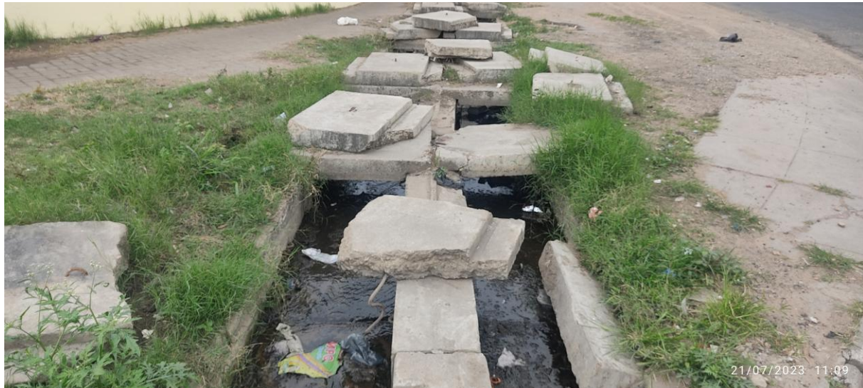
Figura 3-1: Malanga – Vala Existente – Troço 5 – Fotografia ilustrativa do mau estado de conservação
