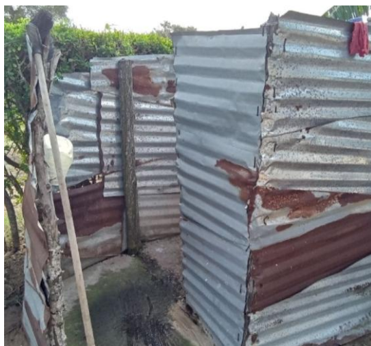
Anexo sanitário de chapa de zinco
