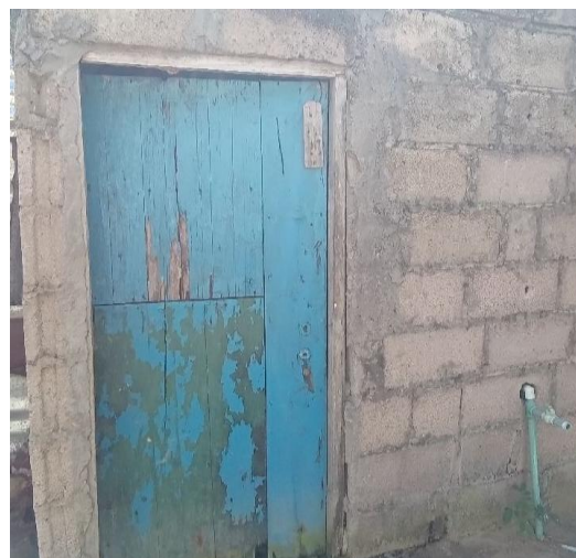
Anexo sanitário de bloco de cimento
