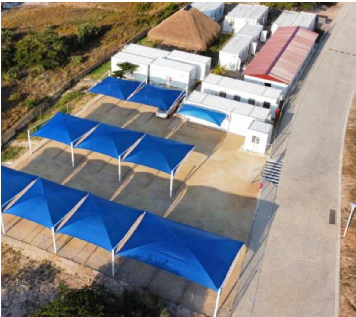
Alpendres para estacionamento com estrutura metálica e rede de propileno.
