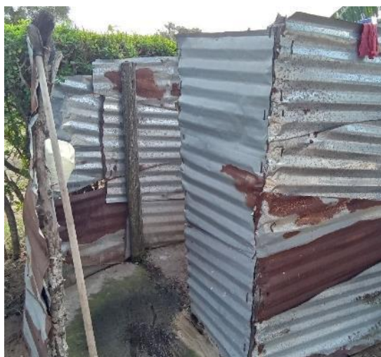
Anexo sanitário de chapa de zinco
