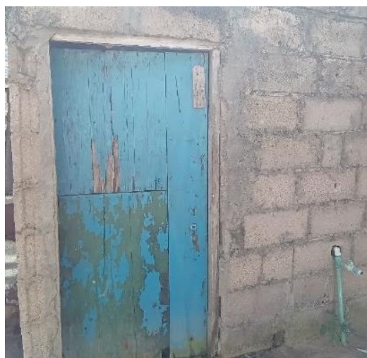
Anexo sanitário de bloco de cimento
