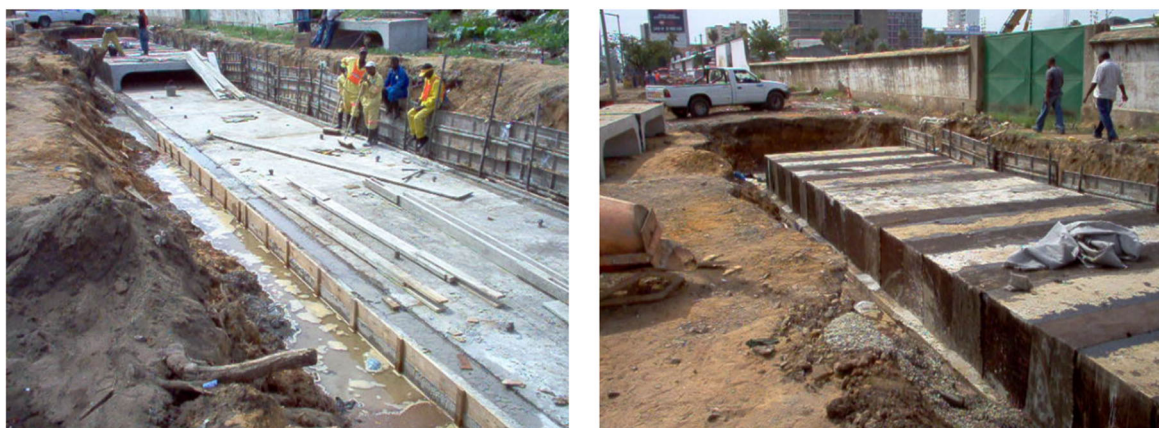
Figura 4-10 Fotografias ilustrativas da construção das box-culvert
