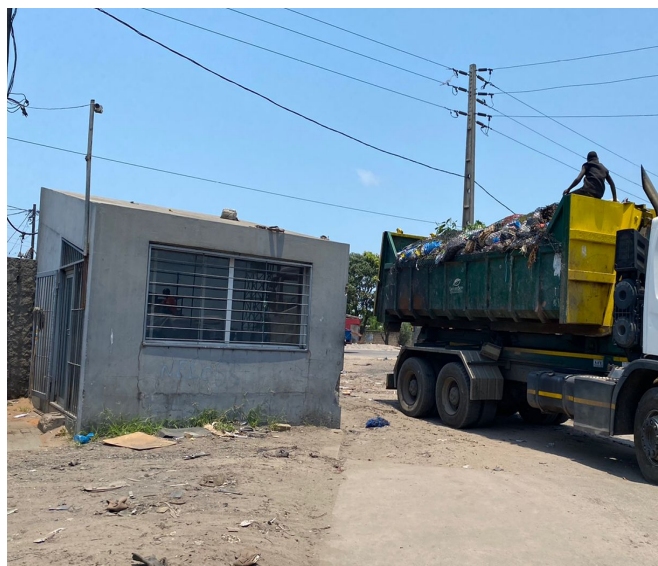
Imagem 74 – Edifício da portaria da Lixeira de Hulene.
