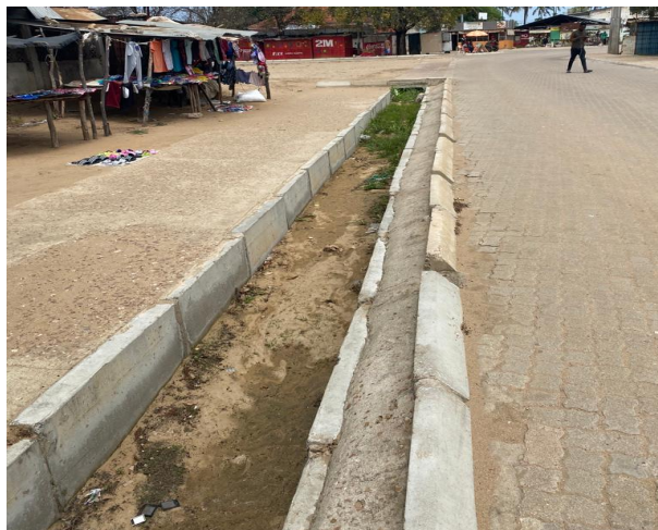
Imagem 15 – Vala de drenagem na Rua 403
