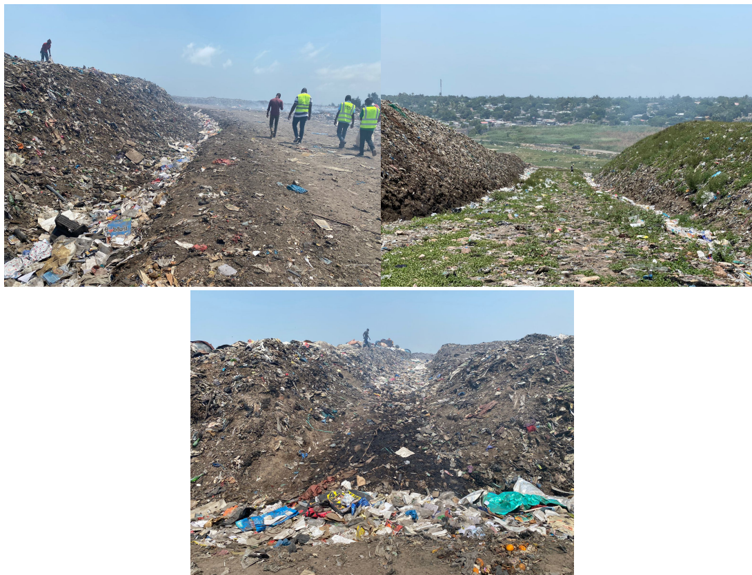
Imagem 78 – (a) vala de drenagem que escoam em direcção a entrada da Lixeira, (b) escoam em direcção a parte traseira da Lixeira, (c) escoam do centro do maciço para uma das valas da via de acesso interna.
