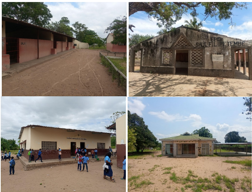
Imagem 8 – a) EP de KaTembe; b) EP Saul Filipe Tembe; c) EP de 1o Grau 10 de Julho; d) Creche de Incassane.
