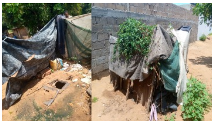
Imagem 61 – (a) Latrina tradicional não melhorada, e (b) casota onde abriga a latrina.
