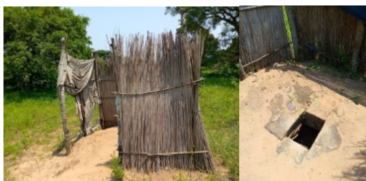
Imagem 63 – (a) Casa de banho feita com material local e (b) latrina tradicional não melhorada.
