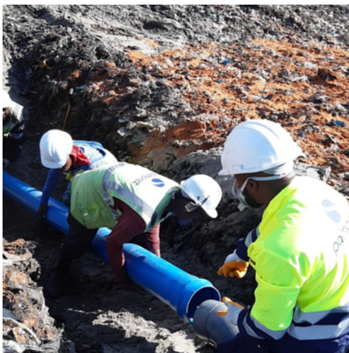
Imagem 80 – Implantação dos colectores de lixiviados na Lixeira.
