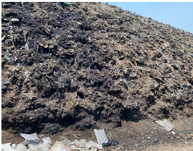
Imagem 81 – Escoamento do lixiviado (mancha escura no talude) para as valas de drenagem de águas pluviais.
