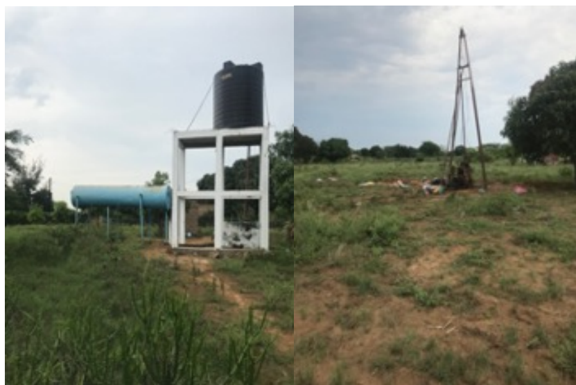
Imagem 51 – (a) Fornecedor Privado de Água da família Dausse e a (b) máquina de perfuração para abertura de furo.
