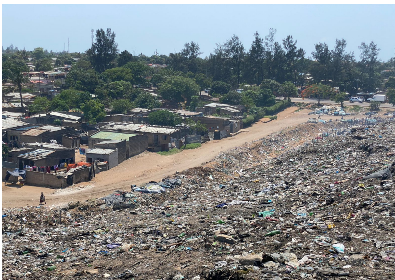
Imagem 79 – Vala periférica localizada a Este do terreno da Lixeira de Hulene.
