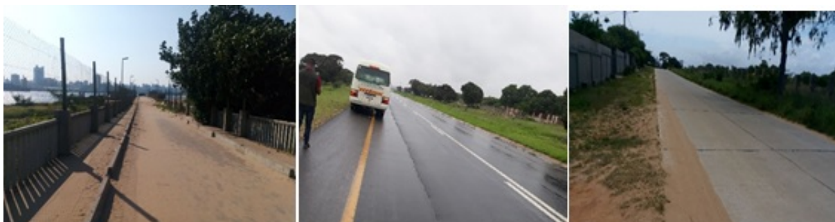
Imagem 14 – Vias principais na área de intervenção (Ponte cais, EN1, Ponte Maputo-KaTembe e Rua 413).
