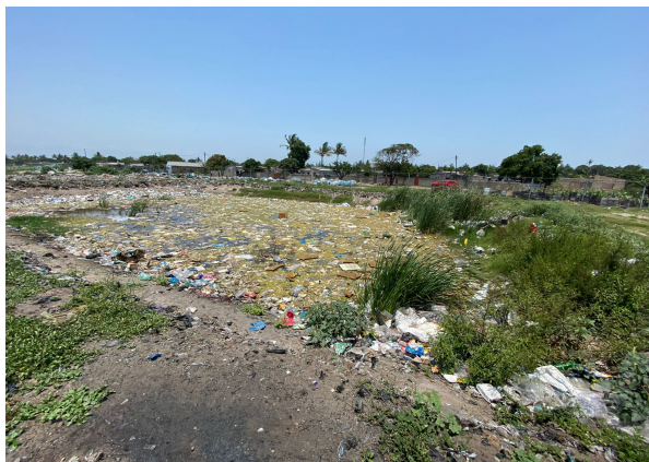
Imagem 77 – Bacia de retenção de águas pluviais.
