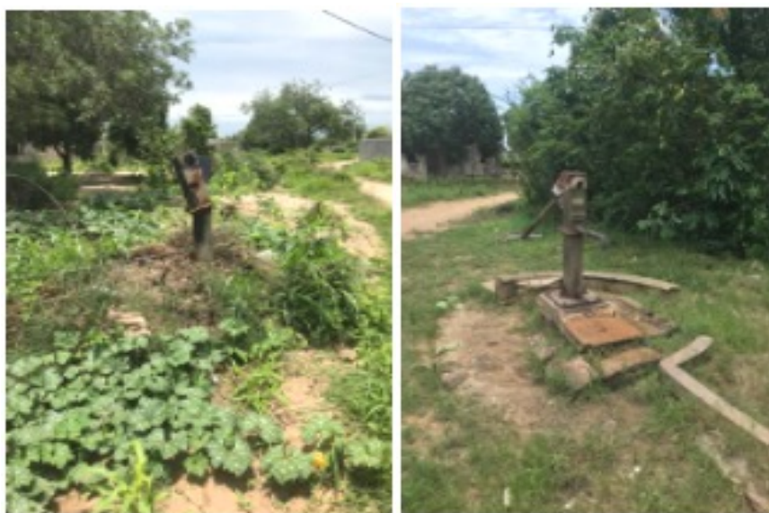
Imagem 34 – Fontenários (a) inoperacional e (b) operacional de bomba manual no quarteirão 2.
