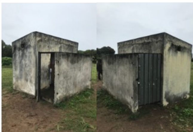
Imagem 41 – Casa de banho do anexo da Escola Primária completa Filipe Sansão Mutemba.
