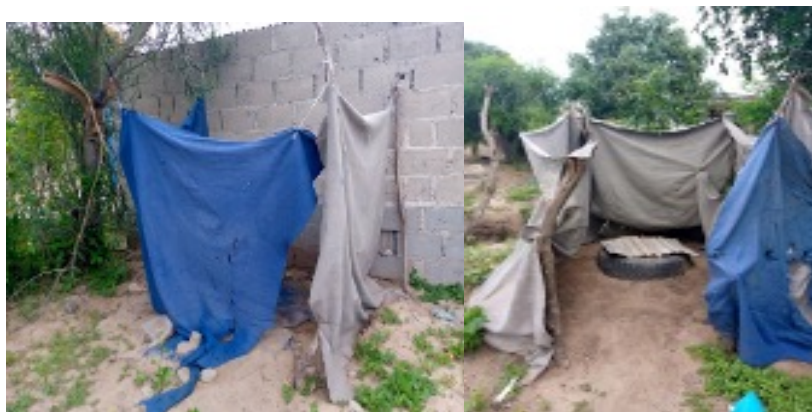
Imagem 60 – Casa de banho e latrina tradicional com revestimento de pneu.
