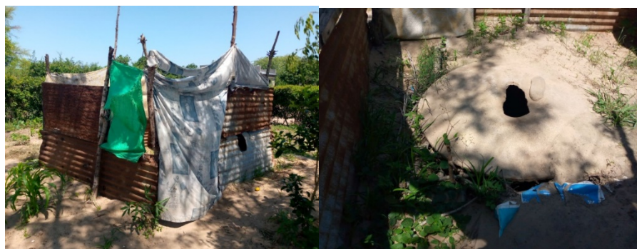
Imagem 59 – Latrina tradicional melhorada e casa de banho feita com material não convencional.
