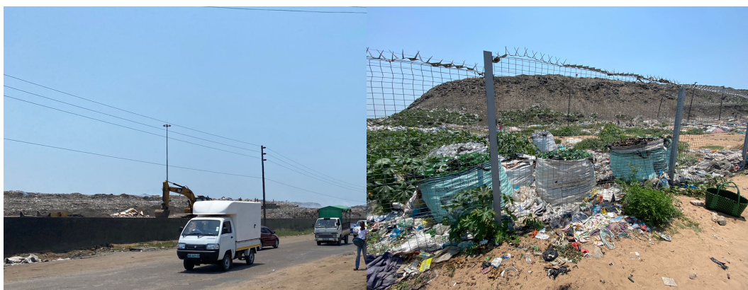
Imagem 72 – (a) vedação em muro e (b) vedação em rede.
