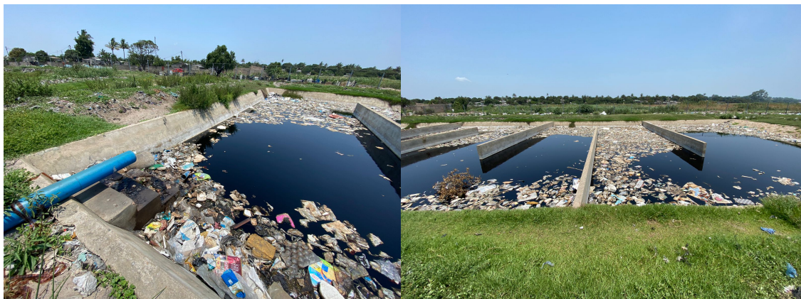
Imagem 76 – Bacia de retenção de lixiviados da Lixeira de Hulene.
