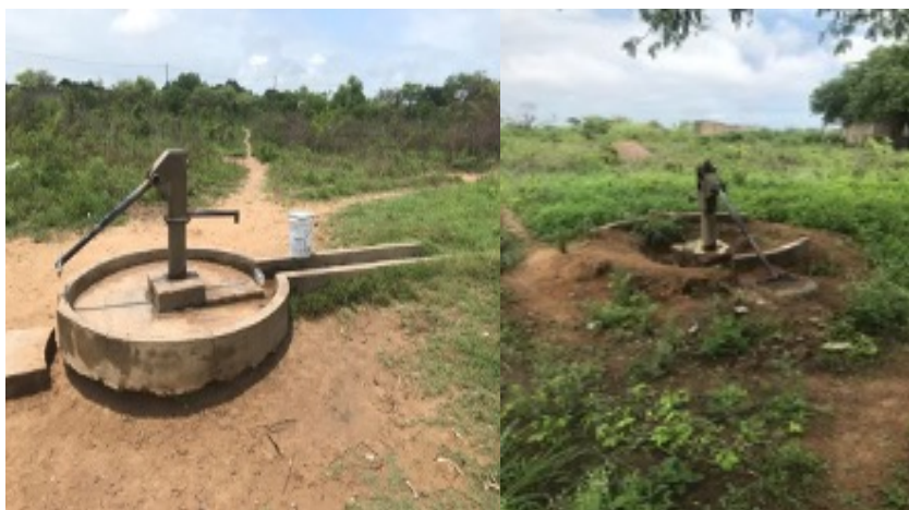
Imagem 52 – (a) Fontenário operacional no quarteirão 14 e o (b) fontenário inoperacional no Q.16.
