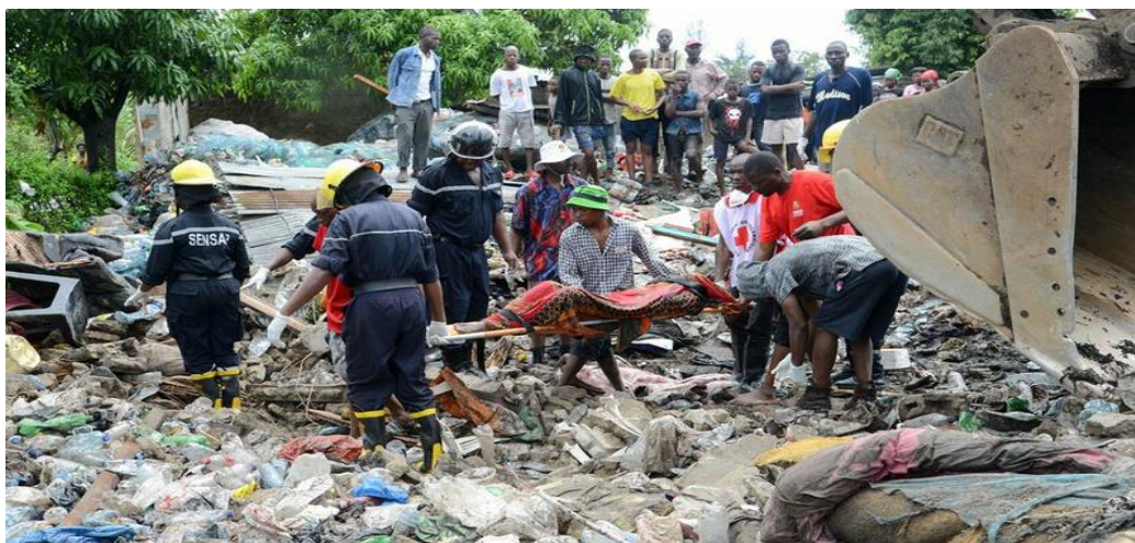
Imagem 71 – Retirada das vítimas do acidente de deslizamento da massa de resíduos da lixeira de Hulene em 2018.
