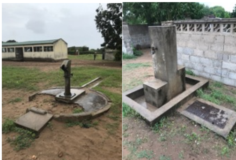
Imagem 40 – (a) Fontanário inoperacional de bomba manual no quarteirão 02, e (b) fontanário operacional de propriedade da AdeM no quarteirão 10b.
