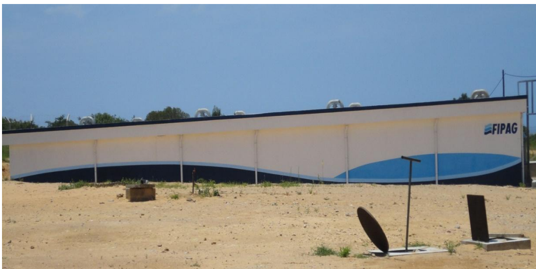
Imagem 31 – Reservatório semienterrado de 2500m 3 .
