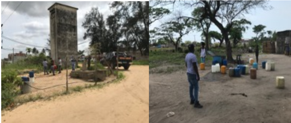
Imagem 44 – Fontanários com (a) fonte de água da FIPAG e com (b) fonte de água do FPA.
