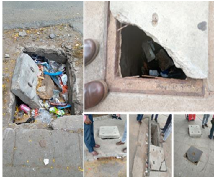
Imagem 13 - Deposição de grandes quantidades de partículas sólidas
