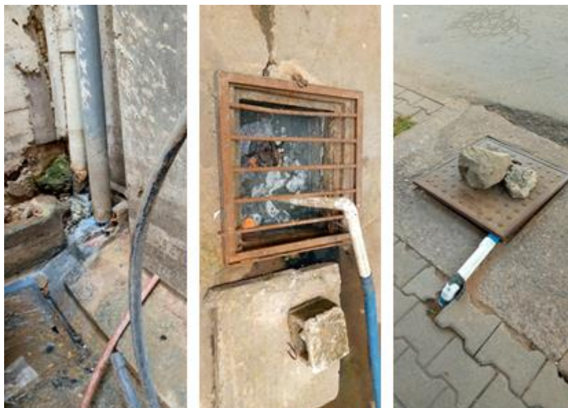
Imagem 11 - Águas provenientes de despejos habitacionais contribuem maioritariamente para os problemas à operação do sistema de esgotos
