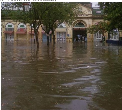
Imagem 8 - Alagamento na Baixa da Cidade de Maputo, Av. de 25 de Setembro
