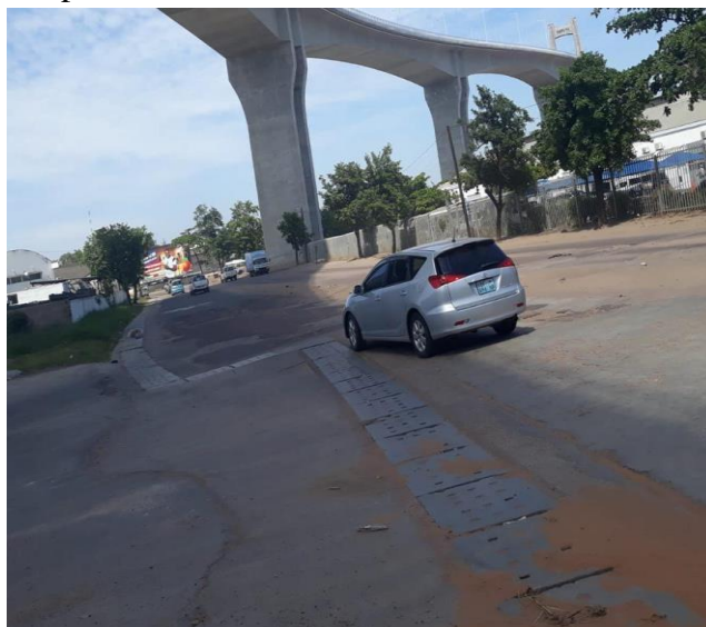
Imagem 5 - Estrangulamento do escoamento na vala e colector obstruído por um dos pilares da ponte
